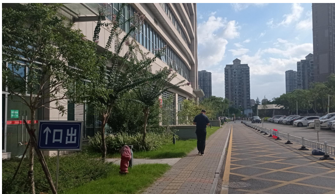
1 号楼南面绿化带及过道
