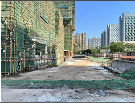
医疗中心大楼东侧
