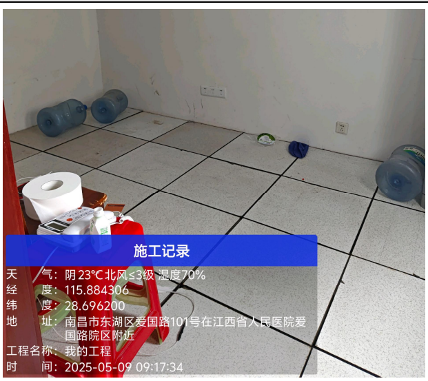
拟改建机房东侧设备间（现为休息室）
