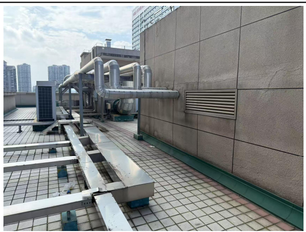
拟建 DSA 机房楼上设备层（室外平台）
