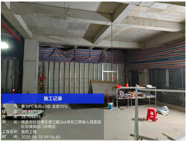
拟建 DSA 机房（原为 1 号手术室）
