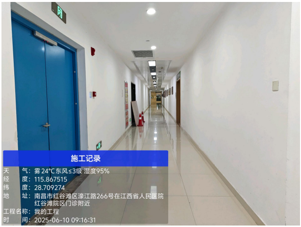
拟建 DSA 机房南侧过道
