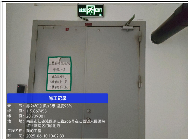
拟建 DSA 机房楼上设备层入口（无关人员无法进入）
