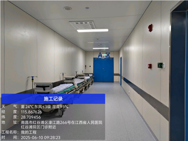
拟建 DSA 机房西侧洁净走廊
