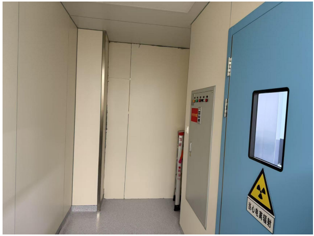
拟建 DSA 机房东南侧污物走廊
