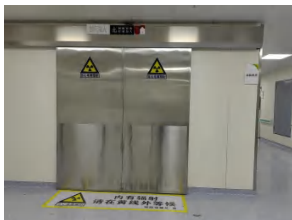
防护门上张贴电离辐射警示标志、门外设置警戒线，门上设置工作状态指示灯
