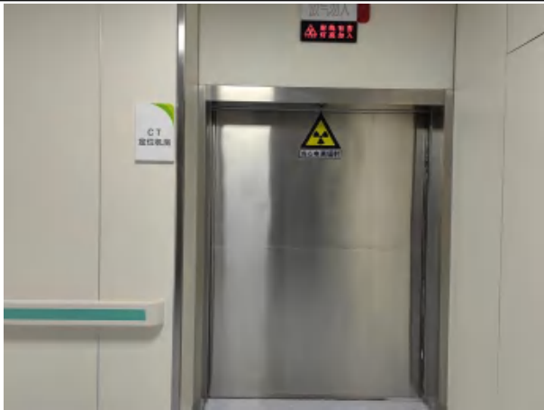
后装机房西侧 CT 定位机房
