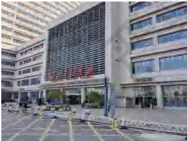
后装机房地 50m 范围北侧为医技/住院楼（医疗综合楼）
