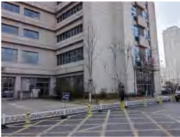
后装机房所在医疗综合楼西侧过道、绿化
