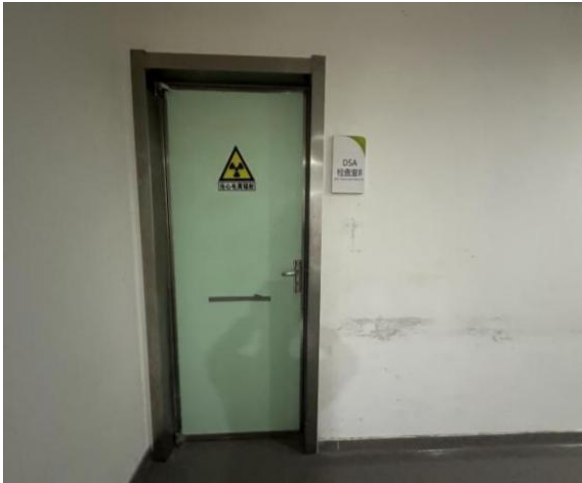
污物通道防护门和电离辐射警告标志
