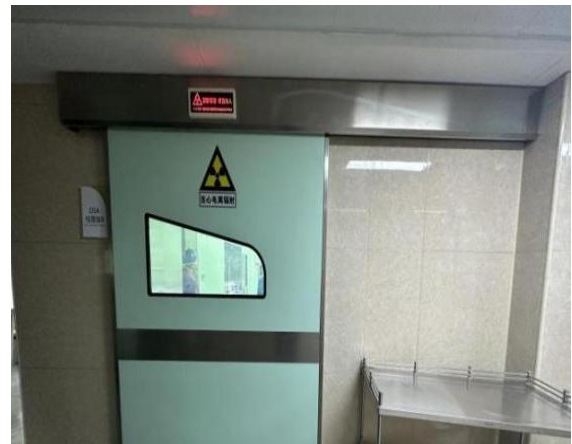
患者进出防护门、电离辐射警告标志和工作状态指示灯
