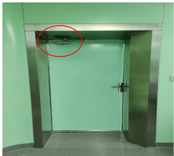
工作人员进出防护门闭门装置
