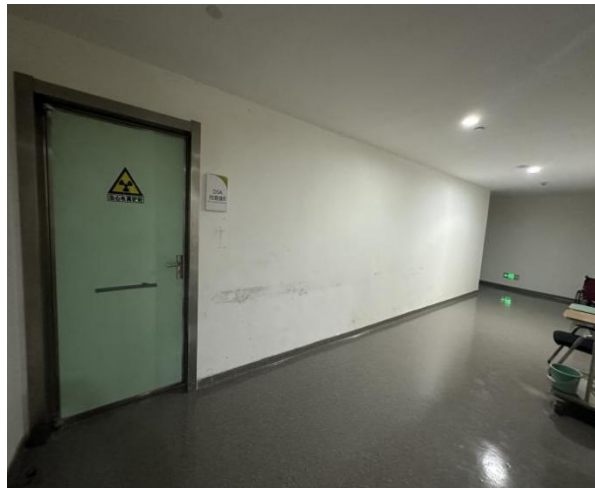
红谷分院医技楼四楼 DSA 检查室 8 南侧
